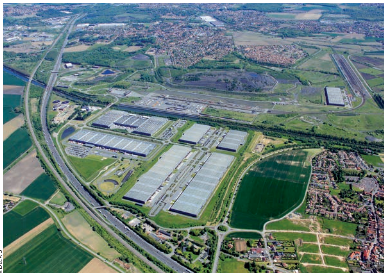
Douges vue générale
